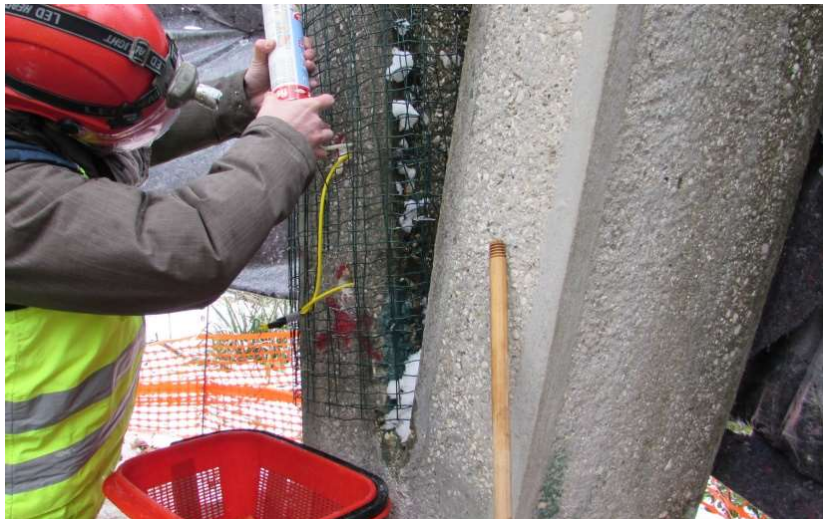
Figura 7 | Sigillatura fori da mina con schiuma poliuretanicca
