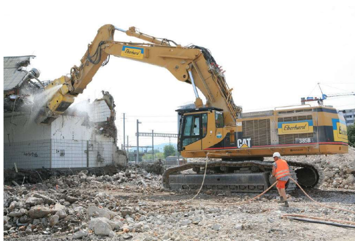
Figura 20 | Ugelli nebulizzatori montati su escavatore con braccio UHD
