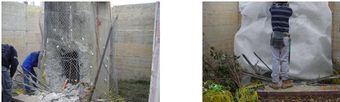
Figura 11 | Predisposizioni di reti di protezione contro lancio di detriti
